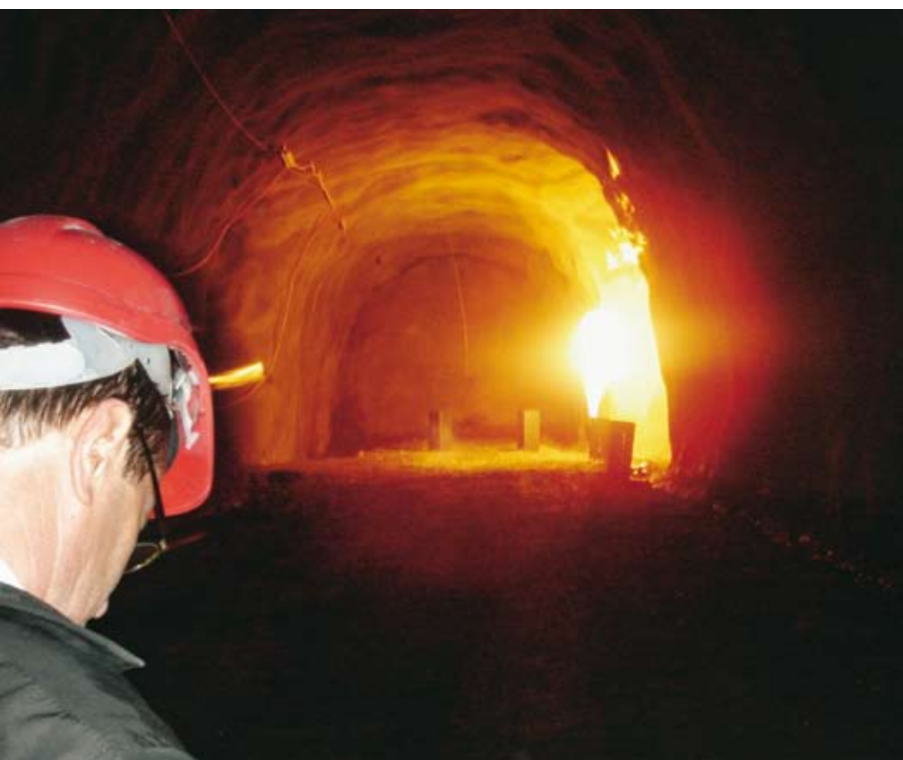
Für die Presse wurde im bereits ausgebrochenen Übungstunnel in Lungern ein bescheidenes Feuer gezündet. Die übenden Feuerwehren können dann bei Bedarf allerdings mit einem Brand über den gesamten Tunnelquerschnitt konfrontiert werden.
